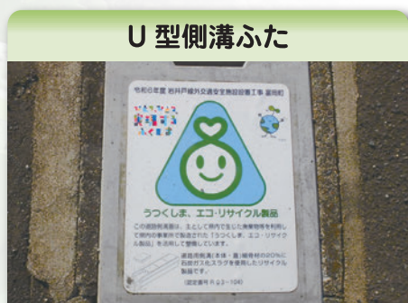
石炭ガス化スラグを利用したU型側溝ふた(富岡町の町道)
