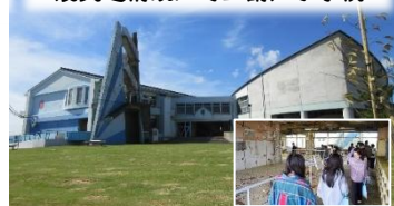
震災遺構浪江町立請戸小学校
