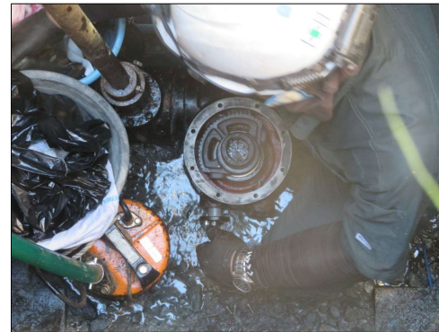
制水弁修繕の様子
