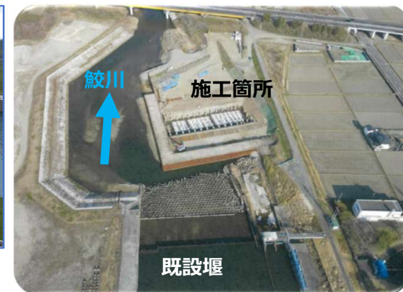
工事中全景 (R8.3)
