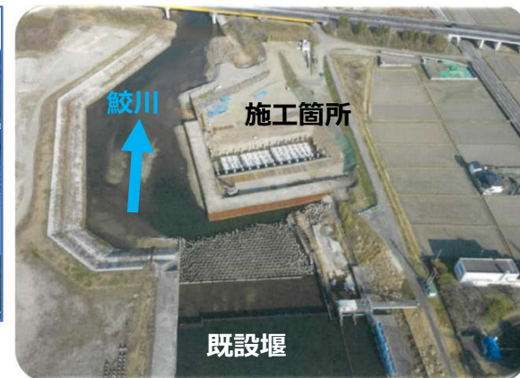
工事中全景 (R8.3)
