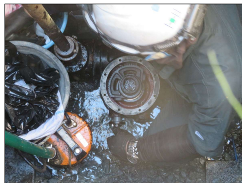
制水弁修繕の様子
