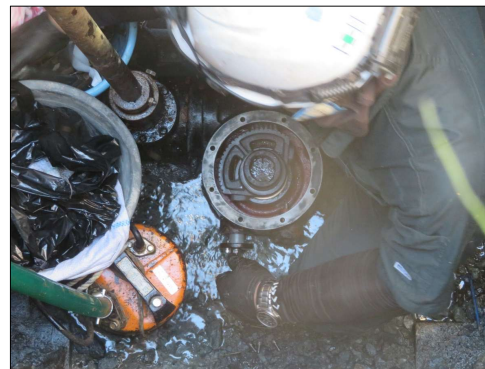
制水弁修繕の様子
