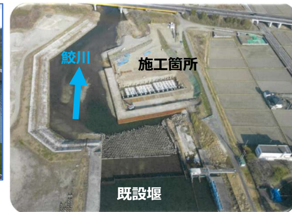
工事中全景 (R8.3)
