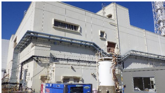
(写真 4 ①) 高温焼却炉建屋 (HTI 建屋)
