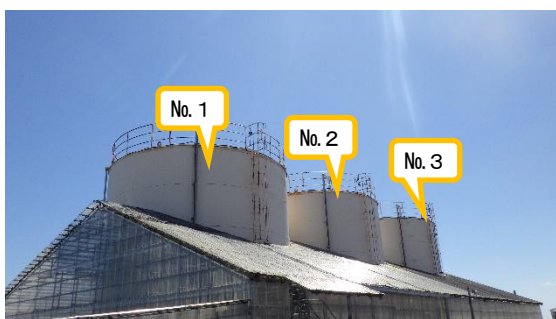
（写真1①）集水タンクNo. 1～3
