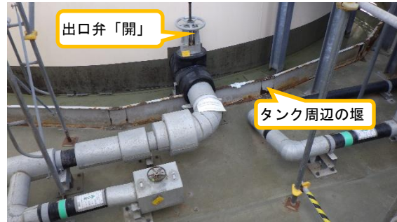
(写真 2) 堰内の様子
