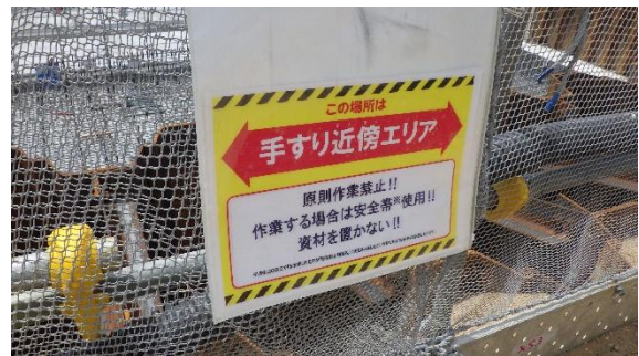
(写真 3 ②) エリア区分及び注意喚起 標示の設置状況②
