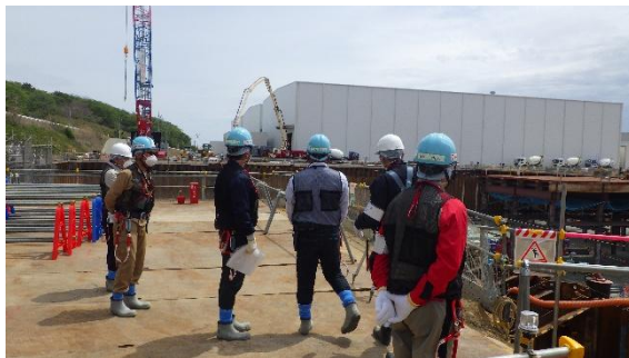
(写真 4 ①) JVによる建設現場安全 確認の合同パトロール実施状況①
