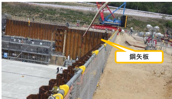
(写真1①) 北東側のエリア状況
