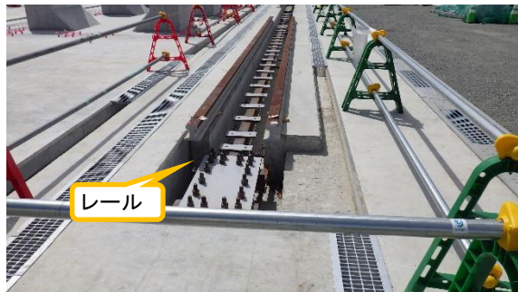
(写真 2 - 2) クレーンのレール設置状況（令和 8 年 4 月 2 1 日の例）
