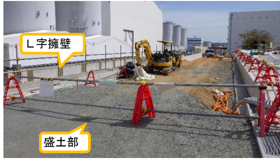
(写真 1 - 2) エリア内の盛り土と土留め施工状況
