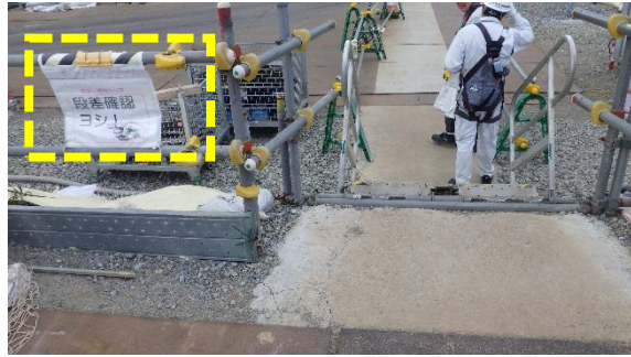
(写真 8 - 2) 現場の安全対策に係る掲示の例②
