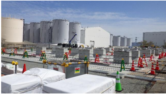
(写真 1 - 1) 増設エリア内の全景
