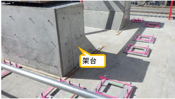
(写真5) 既設の仮保管設備エリアに整備された架台の状況
