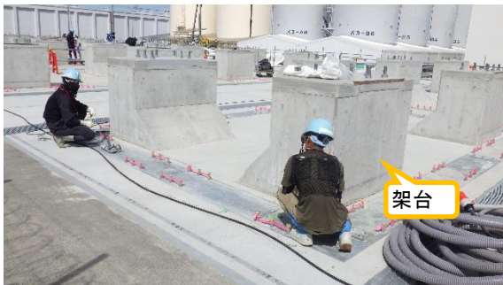
(写真 2 - 1) クレーンのレール溝の設置状況（令和 8 年 3 月 1 6 日の例）
