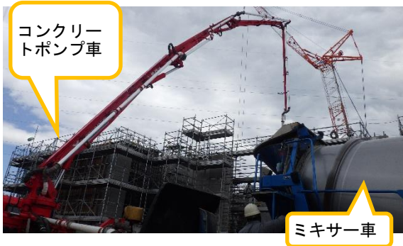
(写真6-1) コンクリート打設の状況
