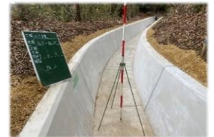
農業水利施設整備
