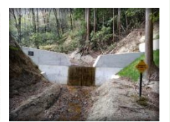
治山施設の整備
