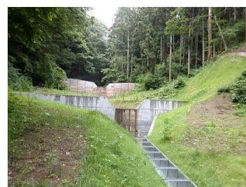
治山事業実施地区 （矢祭町）
