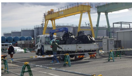
(写真 1-3) 第三施設北側増設工事の状況③ (研り工に係る残土処理等)
