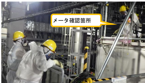
(写真4-1) 増設ALPS建屋内の メンテナンス作業③ (計器類点検)
