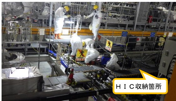
(写真3-1) 増設ALPS建屋内の メンテナンス作業① (A系共沈供給タンク廻り足場作成アンカー打設作業)
