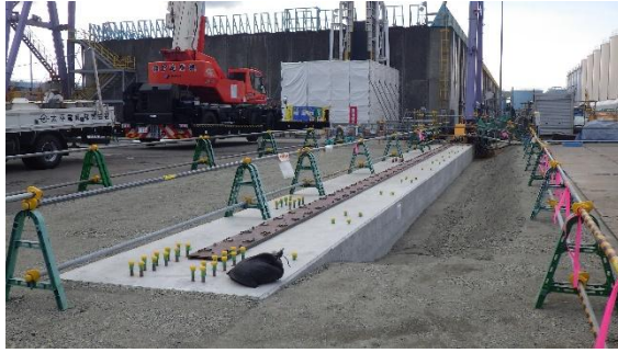
(写真2) 門型クレーン基礎部分の 延伸状況 (西側可動用レール敷設済)
