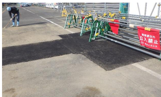
(写真 1-4) 第三施設北側増設工事の状況④
