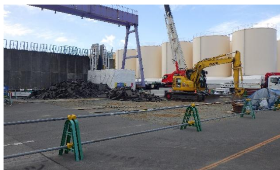
(写真 1-2) 北側増設工事の状況②
