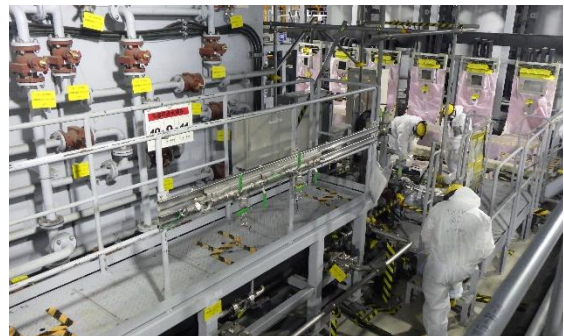
(写真4-2) 増設ALPS建屋内の メンテナンス作業④ (フランジ取り外し、復旧及びトルク確認)
