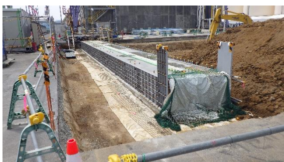
(写真2) 東側のレーン延伸
