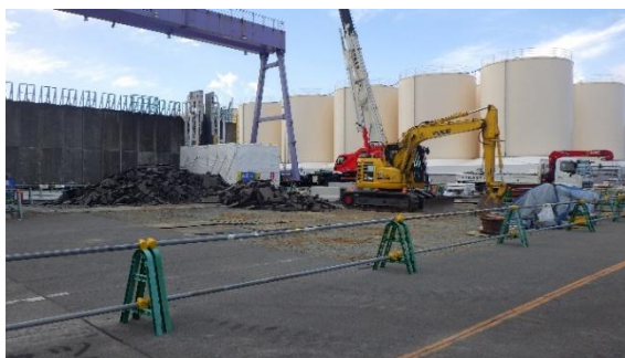
(写真1①) 増設工事の状況① (令和8年1月20日撮影)
