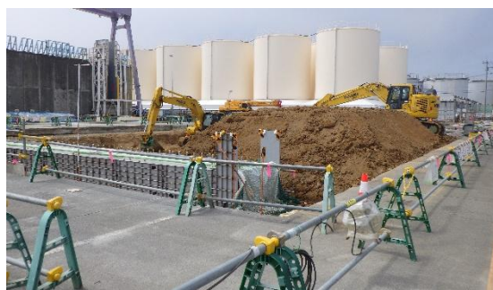
(写真1②) 増設工事の状況② (今回撮影)
