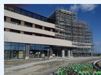
【建設中の宿泊&研修施設】
