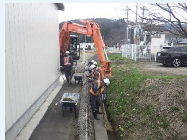
【側溝の土砂撤去奉仕作業】
