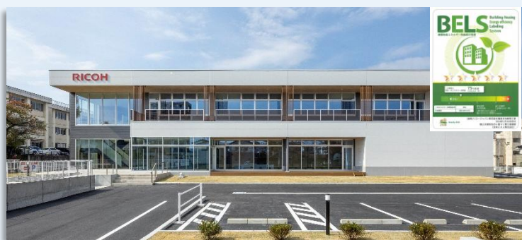
【NearlyZEB事業所（郡山）】
