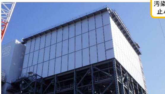
(写真1) 燃料取り出し用構台外観
