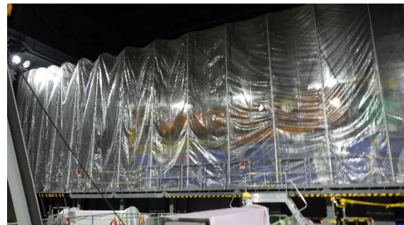
(写真3) 設備への汚染拡大防止ハウス設置状況
