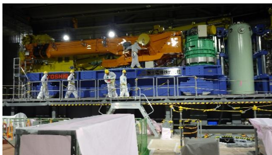
(写真2②) 訓練前の設備点検状況
