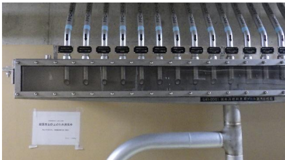
(写真 6-3) 漏えい目視箱 (地下階) の状況
