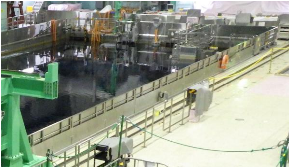
(写真4) 共用プールの状況
