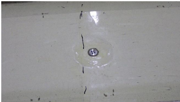
(写真 6-2) 共用プール周辺の床面の排水口
