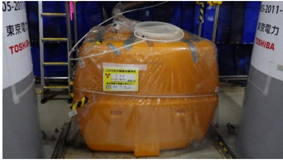
(写真3-3) ドレンライン下に設置されたタンク の状況
