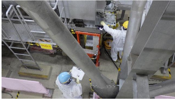
(写真 2 - 1) 灰の回収作業の状況
