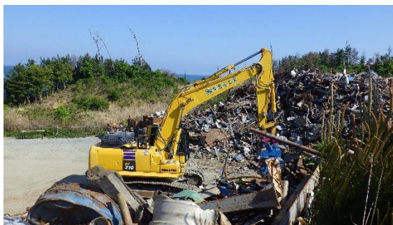
(写真6-2) 金属くず等の保管状況
