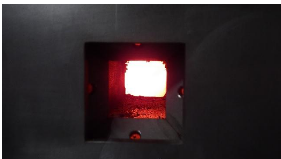
(写真1-2) A系設備の燃焼状況
