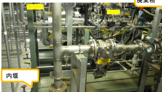
(写真 3 - 3) 焼却炉バーナの系統の状況 内堰内に油の滴下等は見られない。
