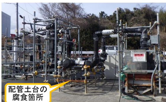
(写真3) 滞留水の移送配管（使用済み）の保管状況
