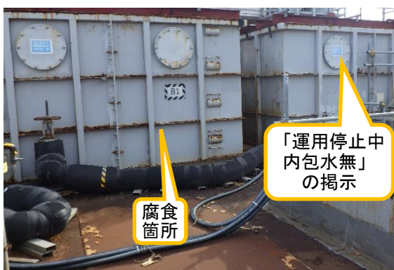
(写真1) F2タンクエリアB群のタンク（フランジ型タンク）の外観
