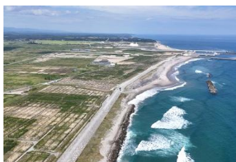
造成された海岸防災林（浪江町）
