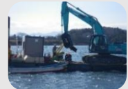
漁場内のがれき等の除去
