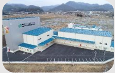
営農再開に向けた施設整備
