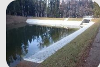
ため池の改修
