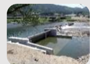
頭首工の改修(埴町伊香堰)
