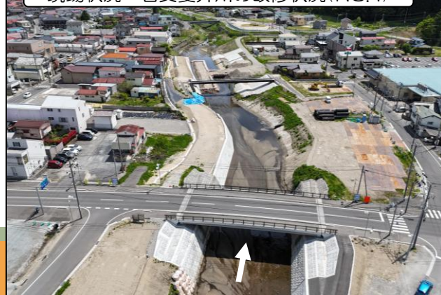
現場状況：右支夏井川の改修状況(R8.4)
