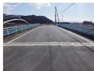
新橋 橋梁補修完了
