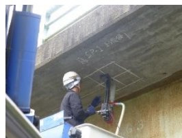
舟津橋 点検状況
