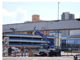
わかば歩道橋 点検状況
