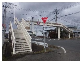
原歩道橋 橋梁補修完了
