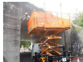
松ノ中ボックスカルバート 点検状況
