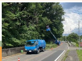
道路支障木伐採
