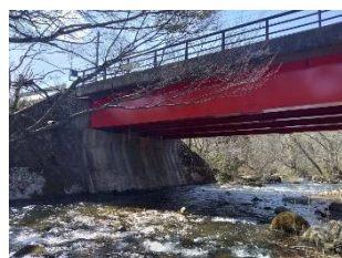
坂口橋 橋梁補修完了
