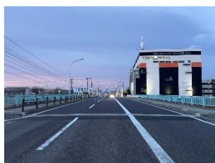
逢瀬川橋 橋梁補修完了
