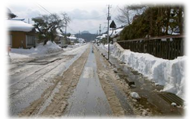
除雪（排雪）後状況
