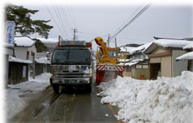
除雪（排雪）中状況
