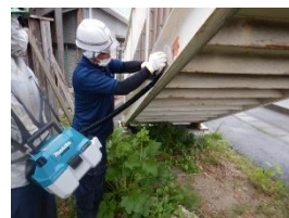
原歩道橋 点検状況
