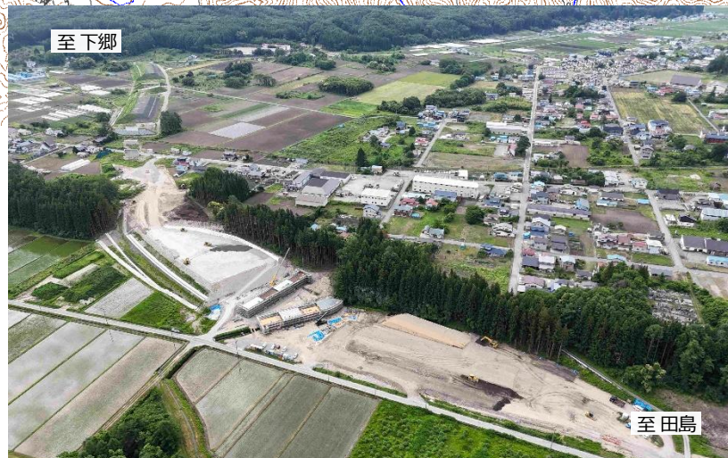
南会津町櫃ヶ島地区(道路改良(盛土)・函渠工施工状況)
