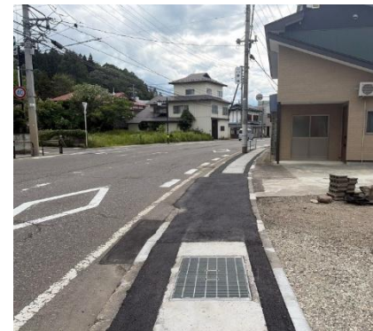
R8工事完了後
