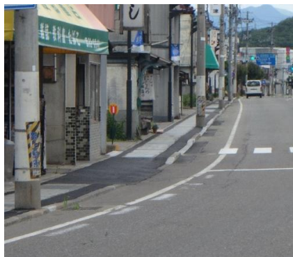
R8工事完了後
