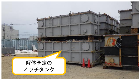
(写真 2－3) エリア D D 西側に搬入された解体予定のノッチタンク群
