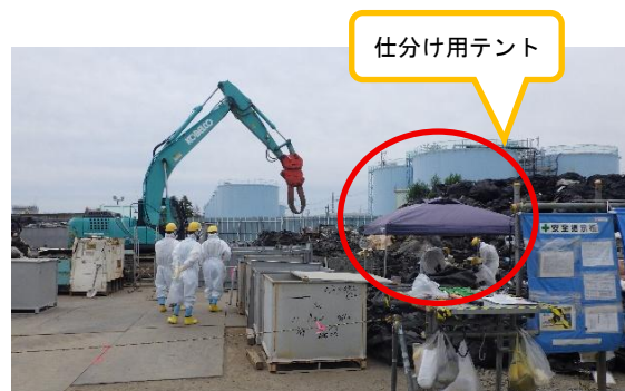
(写真 1－2) エリアDD東側における作業状況② (廃棄物の分別)
