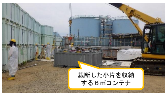
(写真 2－1) エリアDD西側における作業状況① (ノッチタンク裁断①)
