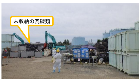
(写真 1－1) エリアDD東側における作業状況① (全景)
