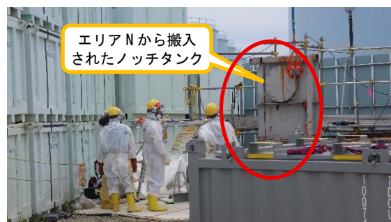
(写真 2－2) エリアDD西側における作業状況② (ノッチタンク裁断②)
