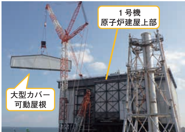
1号機原子炉建屋上部を覆う大型カバーの設置作業の実施状況（令和7（2025）年11月時点、福島県撮影）
