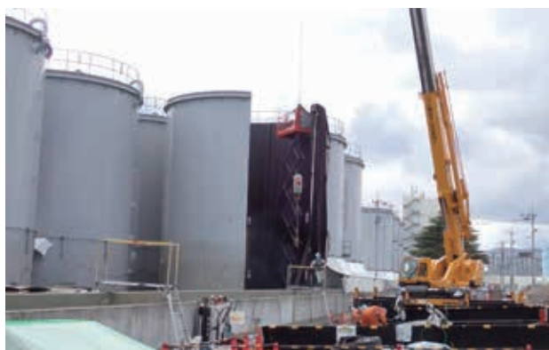
J 9 エリアにおける溶接型タンク解体作業の実施状況（令和 7（2025）年 4 月時点、福島県撮影）
