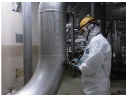
汚染状況調査（サーベイメータによる線量等量率測定）の実施状況
