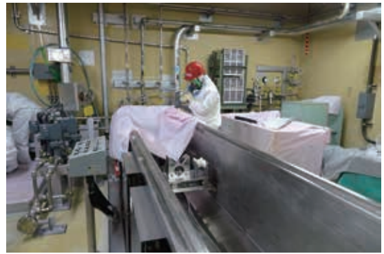
汚染の除去作業状況（東京電力提供）
