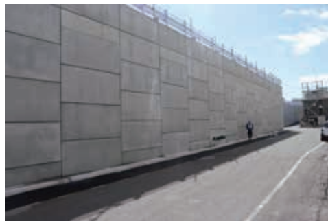
完成した日本海溝津波防潮堤
