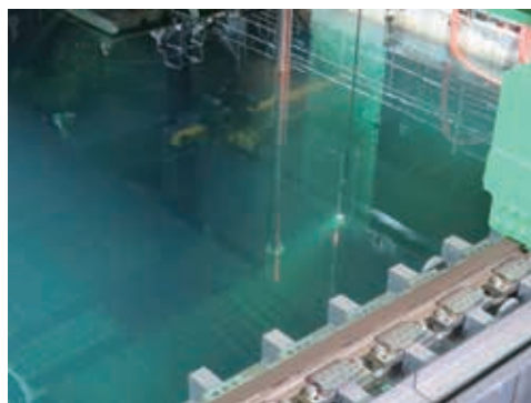
4号機使用済燃料プールの燃料移動 （写真提供：東京電力）
