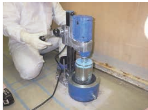
汚染状況調査（建屋試料採取）の実施状況
