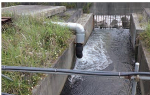
地下水バイパス排水状況
