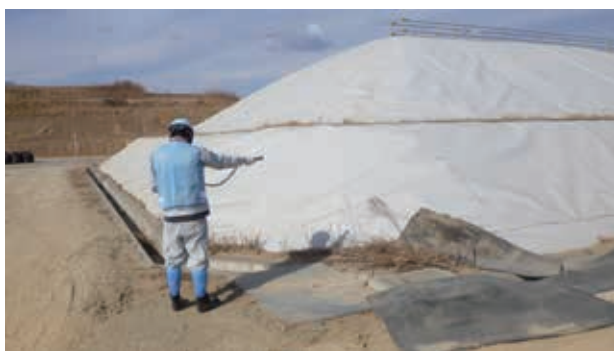
覆土式一時保管施設（一時保管エリアL）におけるガレキ類の保管状況（令和8（2026）年2月時点、福島県撮影）
