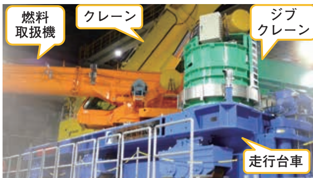
2号機燃料取り出し用構台における燃料取扱設備の設置状況（令和7（2025）年9月時点、福島県撮影）
