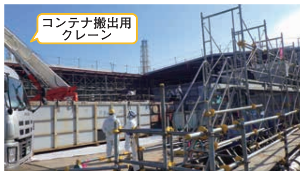
ガレキ類一時保管エリアNにおける汚染土壌のコンテナへの収納作業の実施状況（令和8（2026）年2月時点、福島県撮影）
