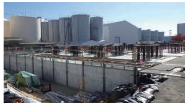
使用済燃料乾式キャスク仮保管設備の増設工事（コンクリート打設）の実施状況（令和7（2025）年11月時点、福島県撮影）
