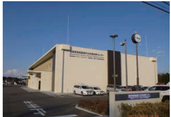
福島県南相馬原子力災害対策センター （南相馬市原町区萱浜字巣掛場45-178）
