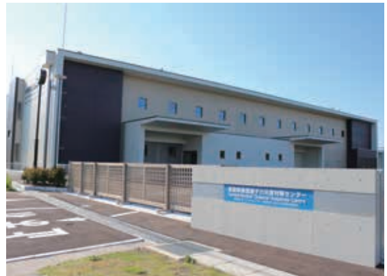
福島県楡葉原子力災害対策センター （双葉郡楡葉町大字山田岡字仲丸1-77）
