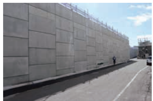
完成した日本海溝津波防潮堤
