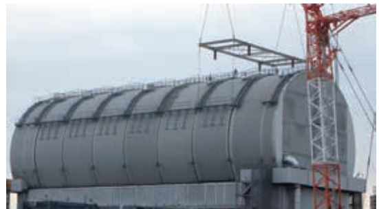
3号機燃料取り出しカバー
