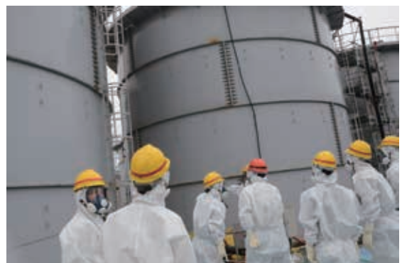
福島県廃炉安全監視協議会によるフランジ型タンクの現地調査の様子
