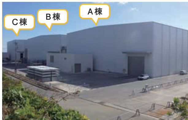
固体廃棄物貯蔵庫第10棟の建設状況（令和7（2025）年11月時点、福島県撮影）
