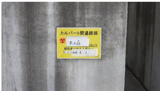
(写真 2－2) ボックスカルバート間通路の空間線量率の表示（0.060mSv/hの表示）
