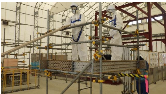
(写真 2－4) ＫＹＴ（危険予知）訓練の状況（模擬 作業現場における危険箇所の抽出）
