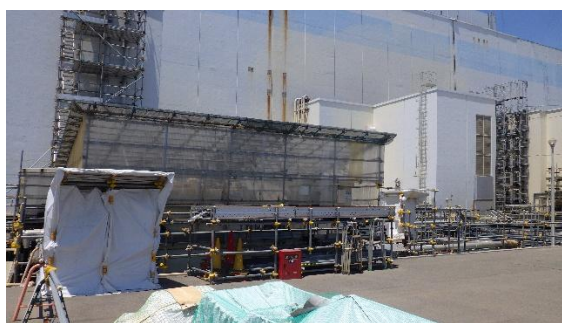
(写真1-1) サブドレン中継タンク設置場所の状況 (No. 1サブドレン中継タンク)
