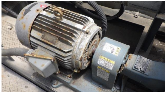
(写真2-2) 移送ポンプの設置状況 (No. 1サブドレン中継タンク)
