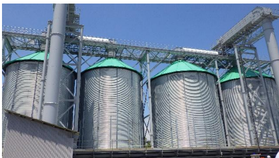
(写真 4 ①) 骨材貯蔵設備
