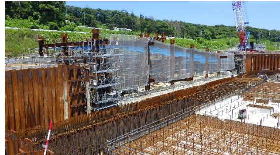
(写真 2 ③) エリア北側の基礎の様子
