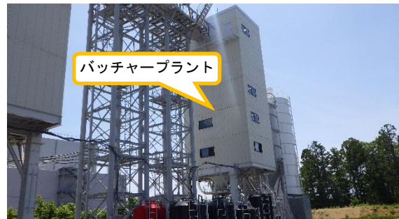
(写真 4 ②) バッチャープラント
