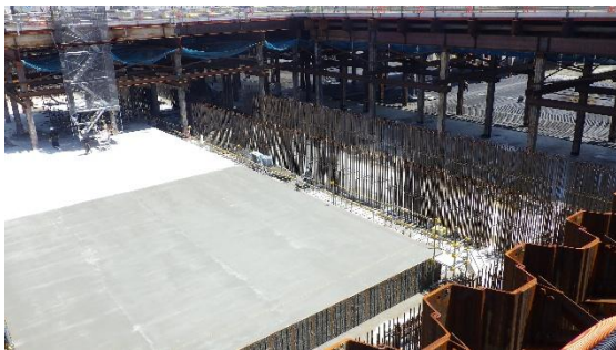
(写真 2 ②) エリア中央の基礎の様子
