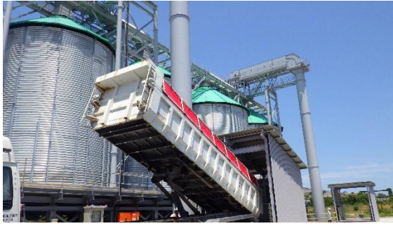
(写真5) 骨材の補充作業
