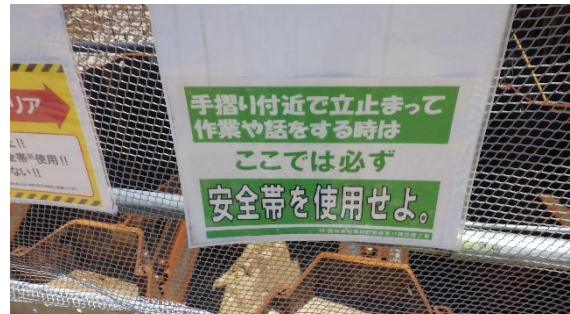
(写真 3 ②) 安全帯着用の掲示
