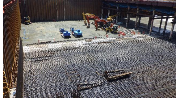
(写真 2 ①) エリア南側の基礎の様子
