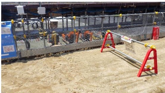
(写真 3 ①) 作業エリアの区分け
