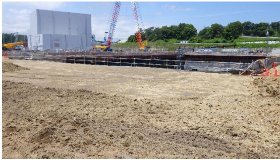
(写真 1) 建設予定地南側からの様子 ※前回までは写真手前側の土砂掘削作業が行われていた。
