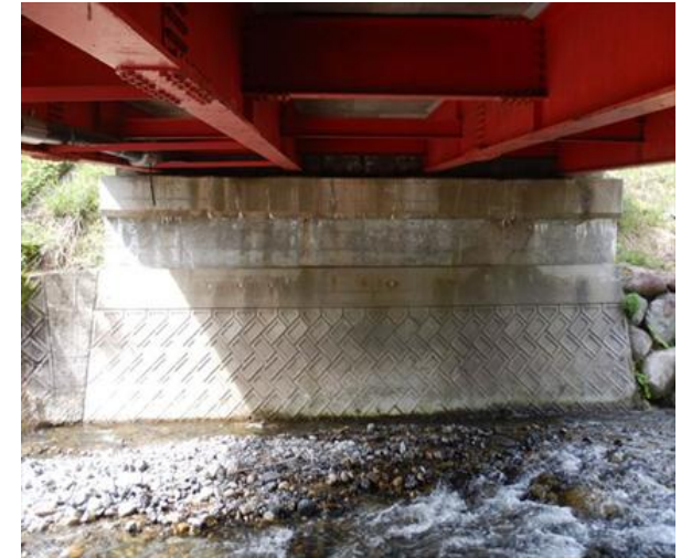
橋梁下面状況(R4点検時)
