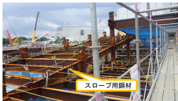
(写真 2－4) 北側搬入口の状況② 鋼材組立は壁面鋼矢板まで進捗
