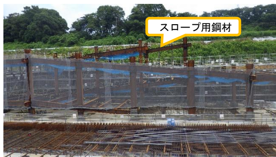
(写真 2－3) 北側搬入口の状況① 運搬車両スロープ用の鋼材組立
