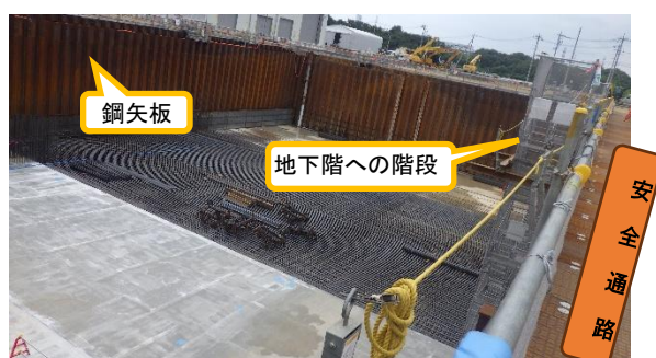
(写真 3－2) 歩廊及び地下階への アクセスルートの確保状況
