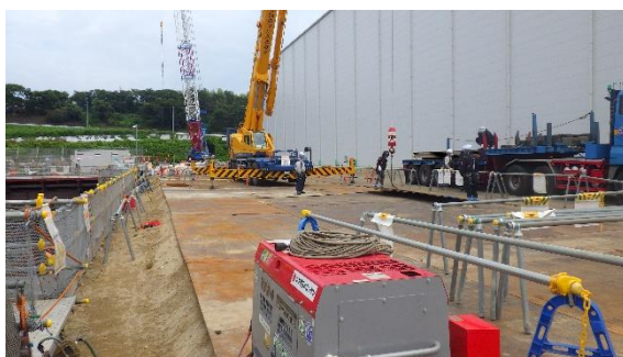
(写真 1－1) 南東側のエリアにおける鉄板の敷設作業
