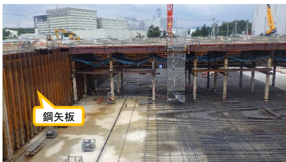
(写真 2－1) コンクリート打設① 南東端の鋼矢板まで P C 打設済み
