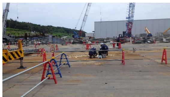
(写真 1－2) 北側のエリアにおける鉄板接合部の溶接作業
