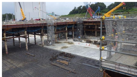
(写真 2－2) コンクリート打設② 北西側 P C 層は多層構造になっている
