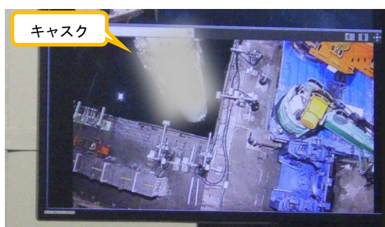
(写真1-1) キャスクのキャスクピットへの吊り下ろし作業の状況①
