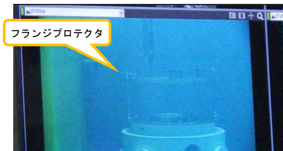
(写真 3) フランジプロテクタの取付け状況
