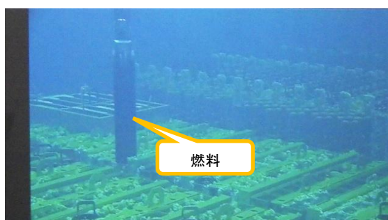
(写真1②) 燃料の取り出し作業②
