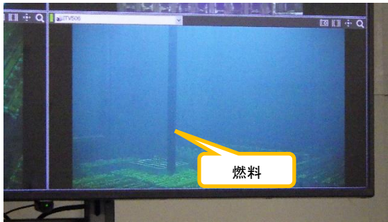
(写真 1 ③) 使用済燃料プール内を移動している 様子
