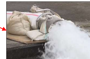
排水先の土のう固定状況
