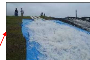
洗掘防止用の養生ブルーシート設置状況
