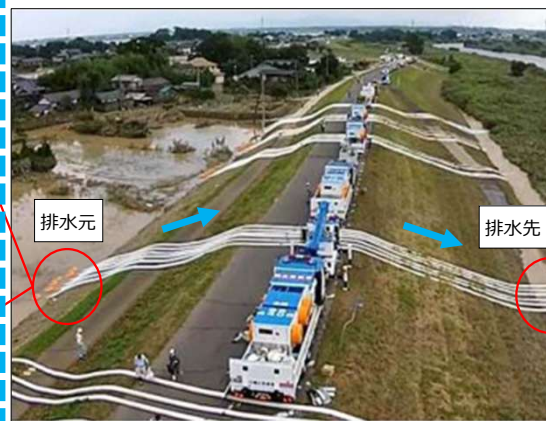
排水ポンプ車設置状況（全景）
