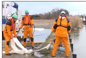
ポンプ・ホース設置状況
