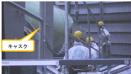
(写真 1－3) 輸送用車両へのキャスク吊り下ろし作業の状況③ (キャスクの横倒し作業後)
