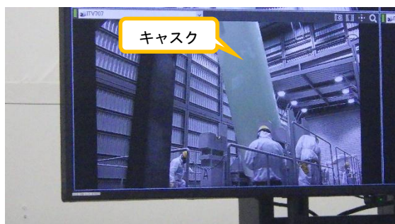
(写真 1－1) 輸送用車両へのキャスク吊り下ろし作業の状況① (キャスクの横倒し作業中)
