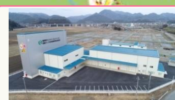
カントリーエレベーター ● 平成31年4月16日完成 ● 米の乾燥、貯蔵、調製、出荷までを一貫して行う ● 300ha分の水稲を処理できる
