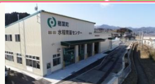
水稻育苗センター ● 平成31年4月16日完成 ● 良質な苗を育て農家に販売支援を行う ● 100ha、2万箱の処理能力を有する
