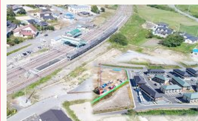
竜田駅周辺整備 ● 竜田駅東側 ・東西自由通路・橋上駅舎を整備
