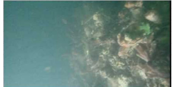
海中の透明度の状況（物揚げ場支柱）
