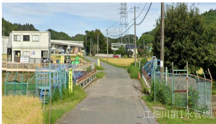
防護柵設置箇所
