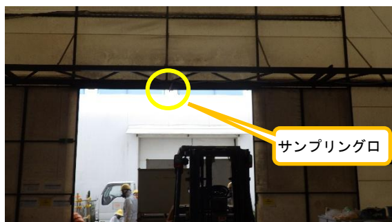
(写真 2－3) サンプリングロ (ジャバラハウス B 内) の状況 (破砕機に近い出入口に設置)
