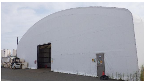
(写真 1－2) ジャバラハウス B (南側)
