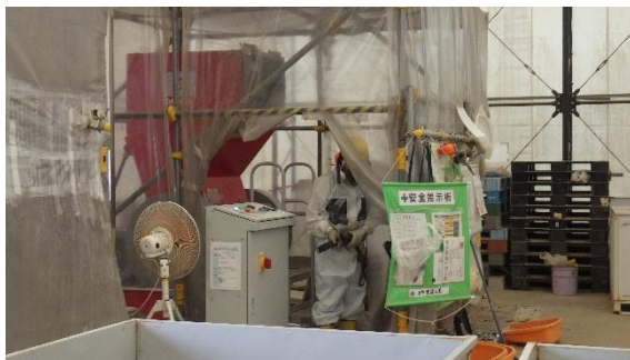
(写真 1－3) ジャバラハウス A 内の破砕機設置状況
