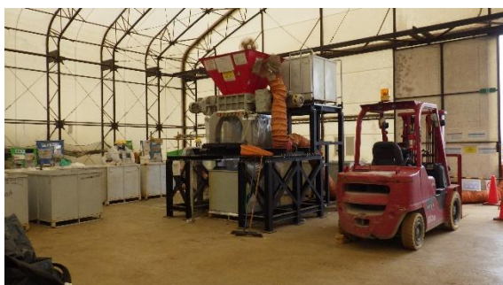
(写真 1－5) ジャバラハウス B 内の破砕機設置状況（北側）
