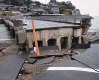
㉓ 久之浜町後 大久川 陰磯橋 (県道 久之浜港線)
