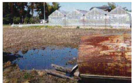
⑦ 渡辺町 ハウス用 燃油タンク 倒壊
