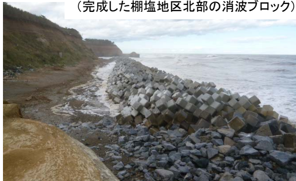
(完成した棚塩地区北部の消波ブロック)
