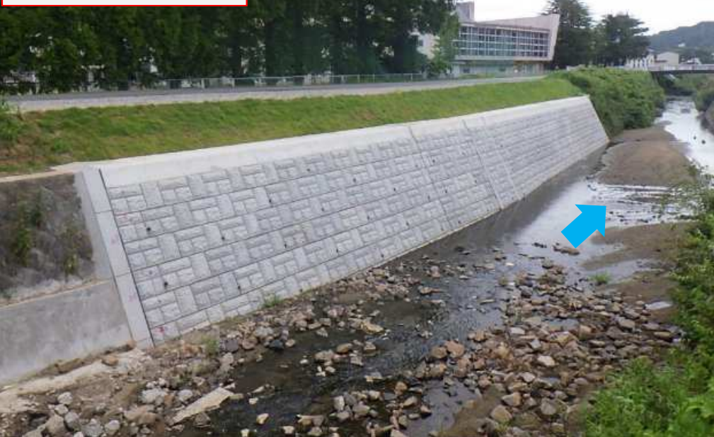
⑤ 宮川(駒谷工区) 完了
