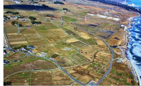
復旧・整備前の農地
