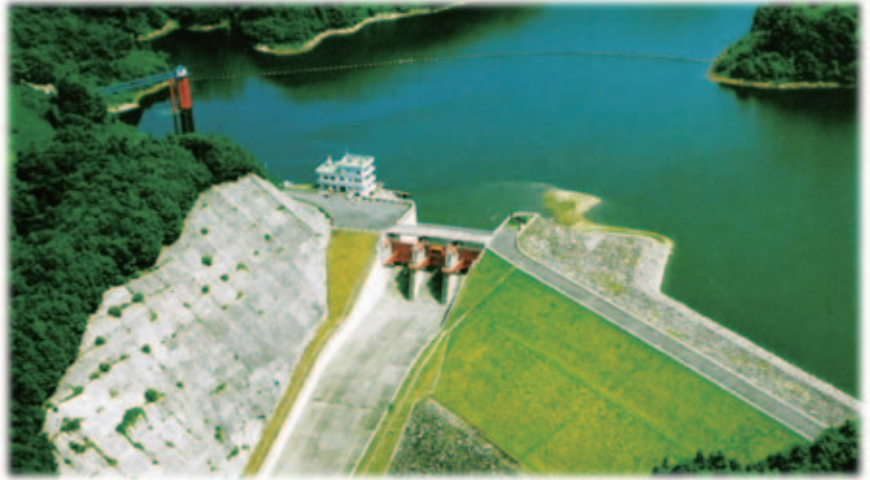
工事着手前の千五沢ダム（平成7年撮影）
