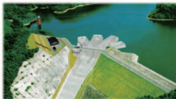
改築後：洪水調節機能あり
