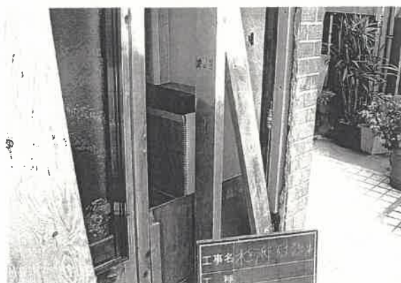
壁面撤去し、間柱および筋かいを設置
