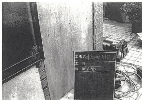
構造用合板(79)設置
